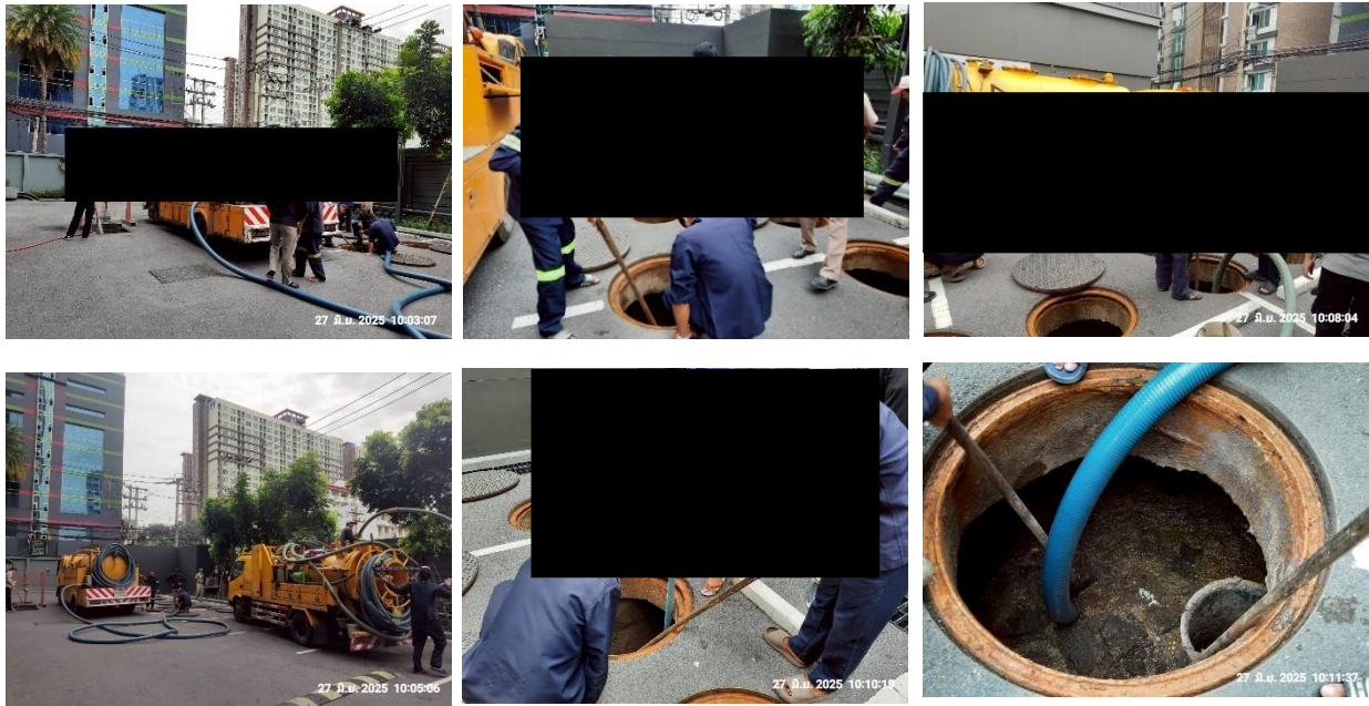
รูปที่ 2-37 สูบล้างภาวูลและตูดไขมัน เมื่อวันที่ 27 มิถุนายน 2568
