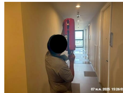
รูปที่ 2-30 เจ้าหน้าที่ตรวจสอบระบบป้องกันและเตือนอัคคีภัย
