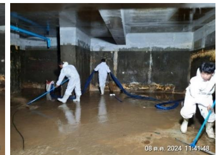
รูปที่ 2-36 เจ้าหน้าที่ล้างถังเก็บน้ำขึ้นใต้ดินและชั้นดาดฟ้า เมื่อวันที่ 8-9 ตุลาคม 2567 ในปี 2568 มีแผนในเดือนตุลาคม
